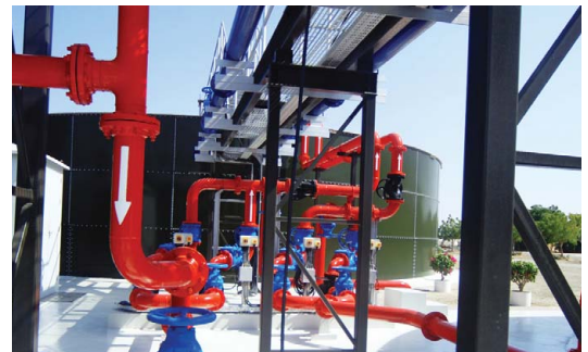
Sharjah Municipality Capitox STP, Sharjah, UAE
